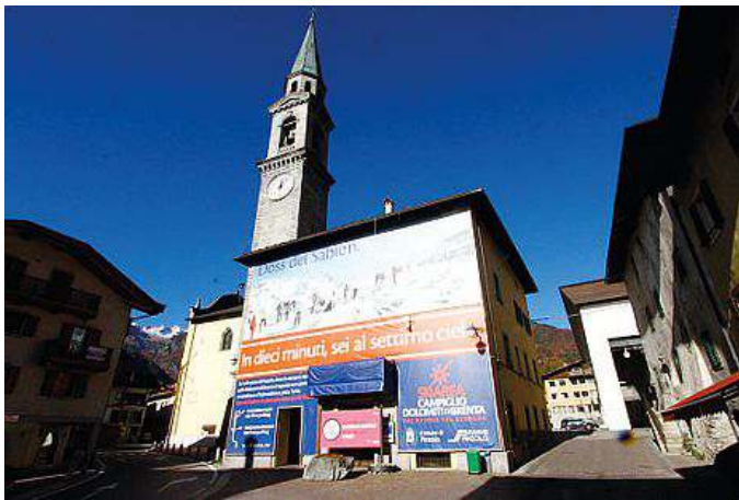
L'ex municipio di Pinzolo: entro l'estate sarà demolito
